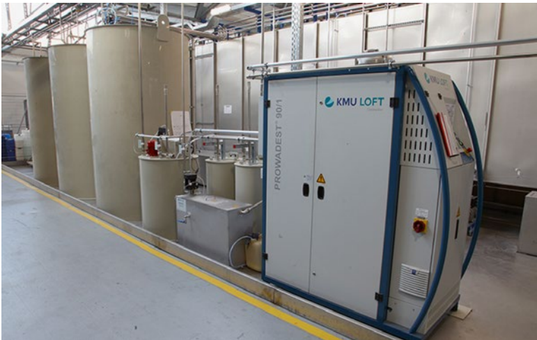
Eine Vakuum-Verdampferanlage zur Schmutzwasserbehandlung und die Kreislauf-VE-Wassertechnik ermöglichen die Wiederverwendung des Destillats als Spülwasser.
