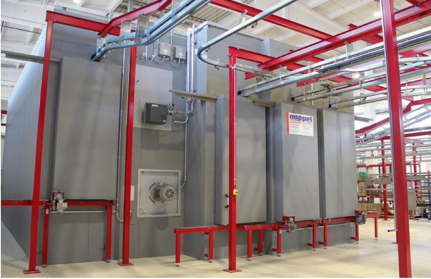
Der zentrale Blockrockner kombiniert einen Haftwassertrockner, einen Pulvereinbrennofen und eine Pulvereinbrennzone für Sonderteile.
